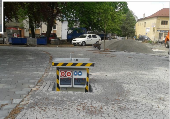
krátce po instalaci sloupku
