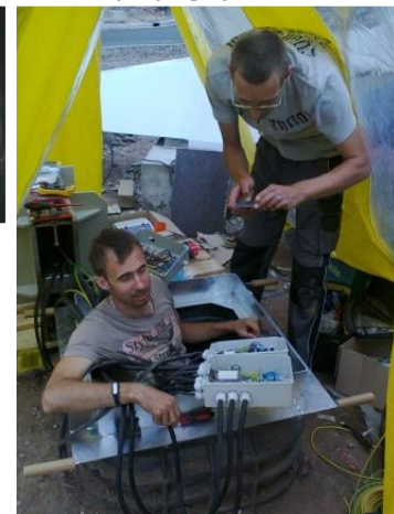
propojení kabeláže všech světelných okruhů v přípojních krabicích
